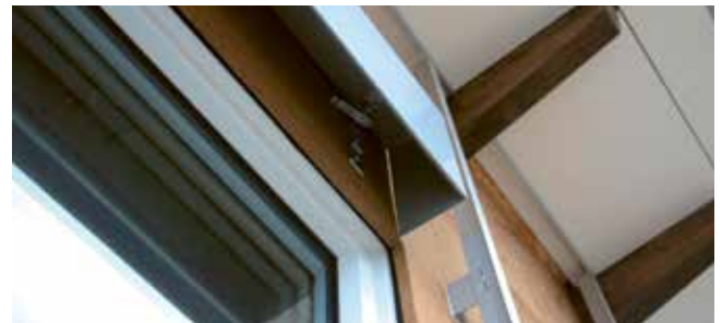
Fensterrahmen-Überdämmung
